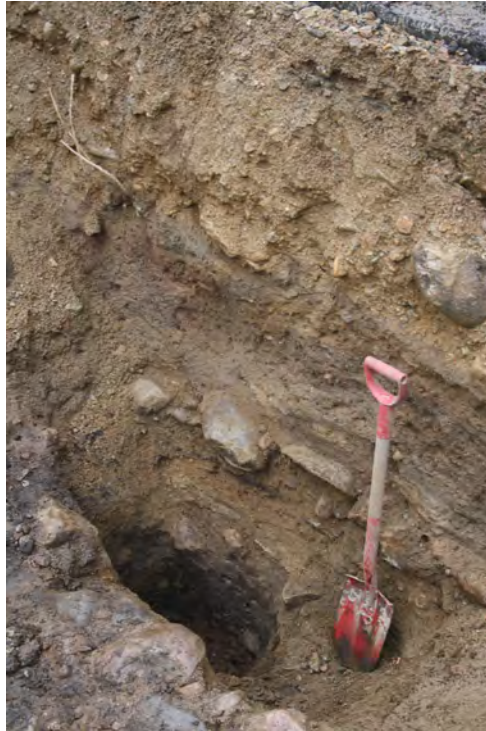
Fig. 45: Sektionen i schakt 314 visade vägens bakgrund från 2000-talets asfalterade gata ned till 1200-talets risbädd. Foto från öster.
